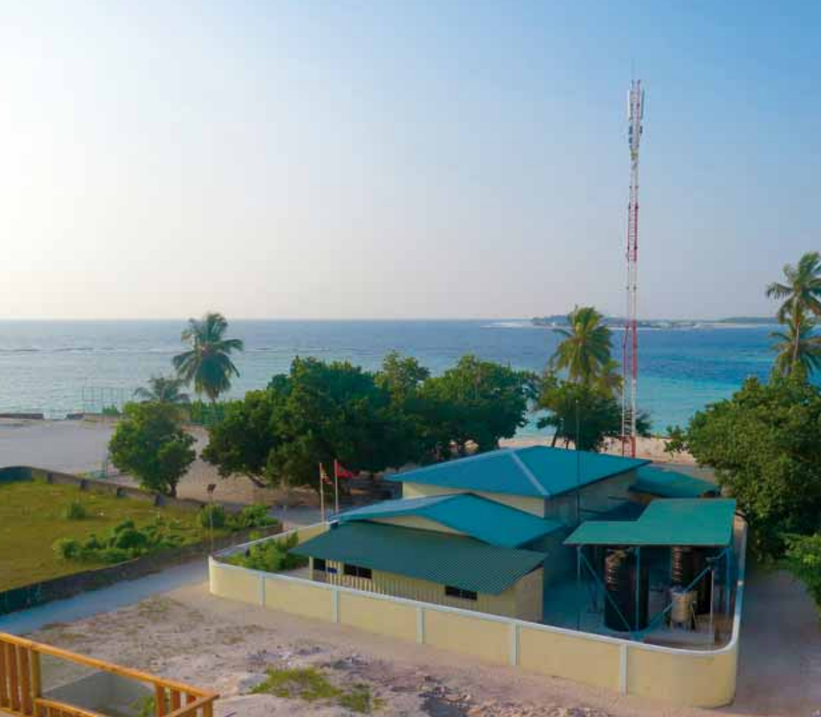
◀ Abbildung 1 Generatorhaus auf der Insel Gulhi (Malediven)
